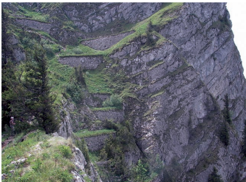
La réalisation et l'entretien des ouvrages de protection deviendront encore plus importants. Un versant aménagé à la Dent de Jaman, Vaud (© E. Reynard)
